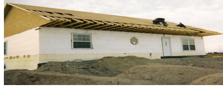
Below is Daniel & Carmen Melgosa...plumber
